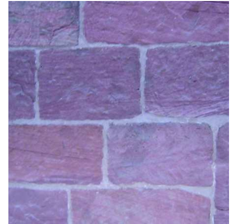
Sandsteinmauerwerk
