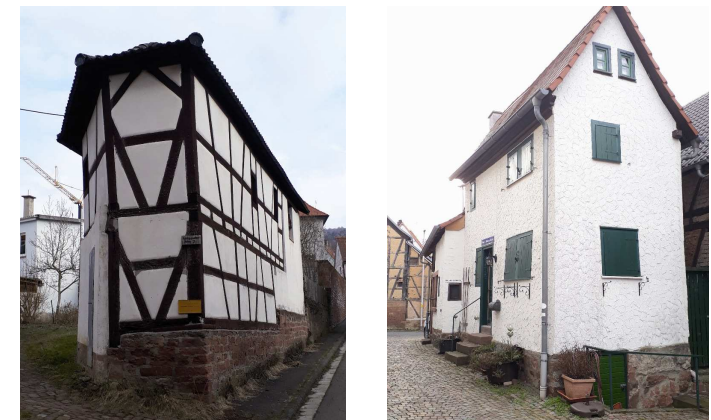
... auch kleine Gebäude prägen das Ortsbild
