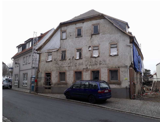
... hier wird saniert
